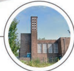
Transformatorhuis bij het station
