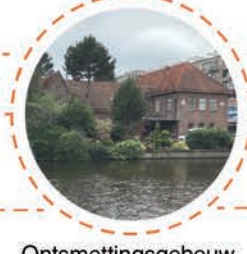
Ontsmettingsgebouw van het Witte Kruis
