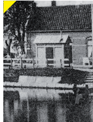
Brugwachtershuisje bij de Koedijkervlotbrug. [RAA]
