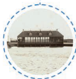
'Doorrijveiling' op de kop van het Afgesneden Kanaalvlak
