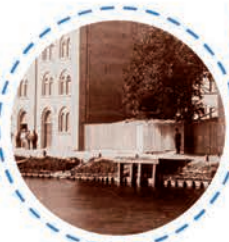
Onverharde oevers met kleine steigertjes langs de polderzijde (Noorderkade)
