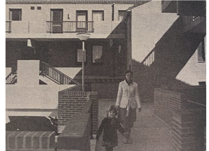
Verhoogde woon- en wandelstraten in de Winkelwaard. [BOUW]
