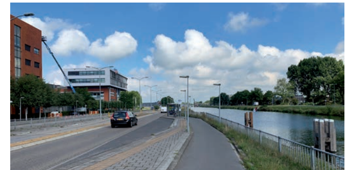
Verbrede Helderseweg, smalle oeverstrekk met hekwerk.
