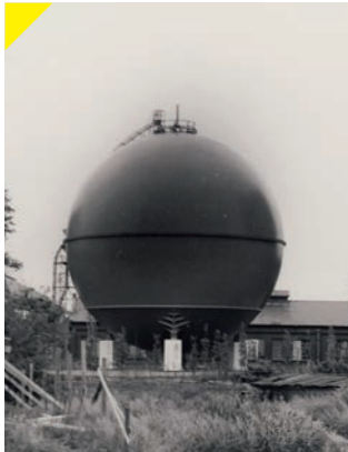
Gasbol van de gasfabriek. [RAA]
